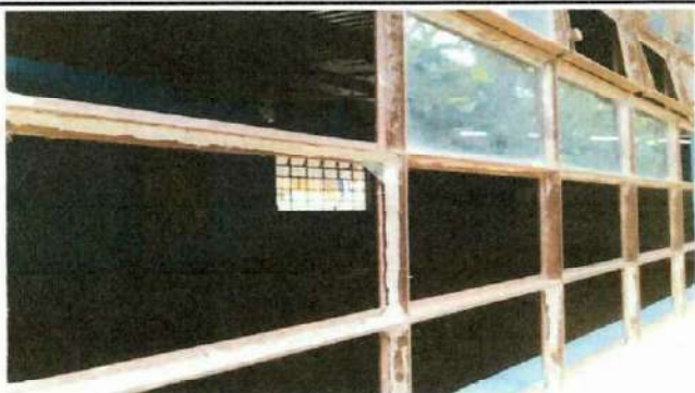
Foto 3: Se observa vidrios quebrados y faltantes en el módulo 1
